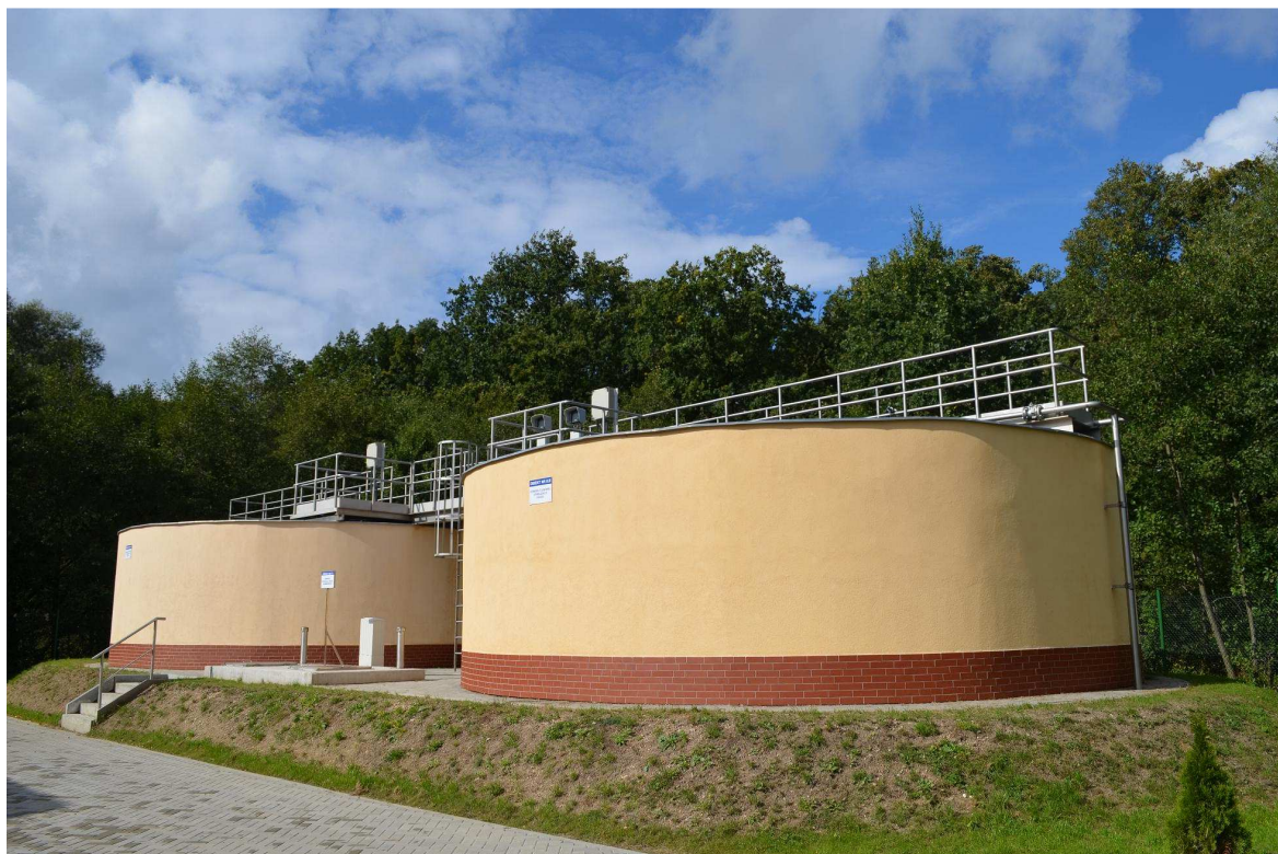
Na zdjęciu: Komory tlenowej stabilizacji osadu
